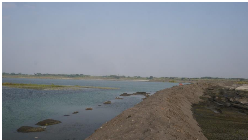
圖 15 枯水期進行清沙時用土堤將河道移至另一側
