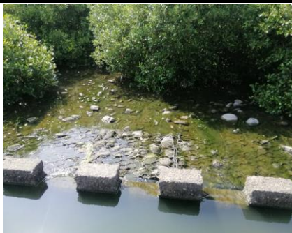
照片〈32〉大潭濕地利用表面水流高低差形式，讓水緩慢流入各區。
