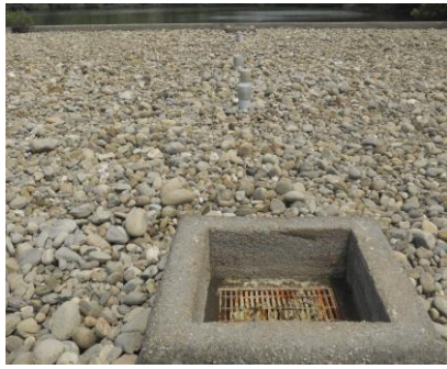
照片〈26〉崎峰溼地利用地下水流形式控制水的流量。
