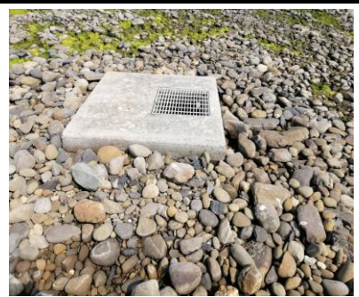
照片〈33〉右岸濕地利用地下水流形式控制水的流量。
