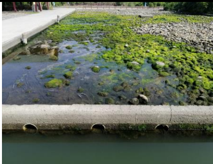
照片〈31〉右岸濕地利用表面水流高低差形式，讓水緩慢流入各區。
