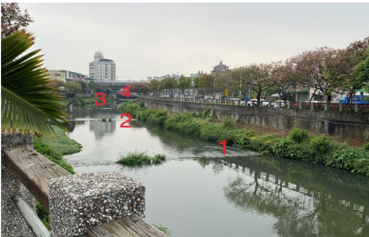
圖 29 從長春橋到玉皇宮前的水利工程-固床工
