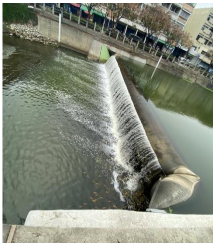
圖 32 復興公園之生態工法～橡皮壩工程、引溪水至公園型水域
