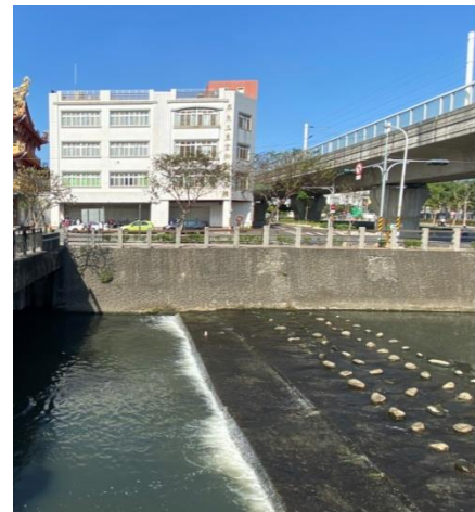
圖 29 從長春橋到玉皇宮前的水利工程-固床工
