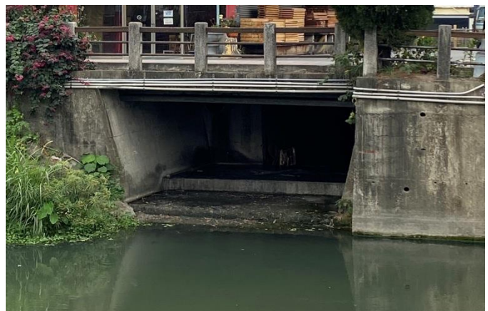
圖 30 從長春橋到玉皇宮前的水利工程-箱涵
