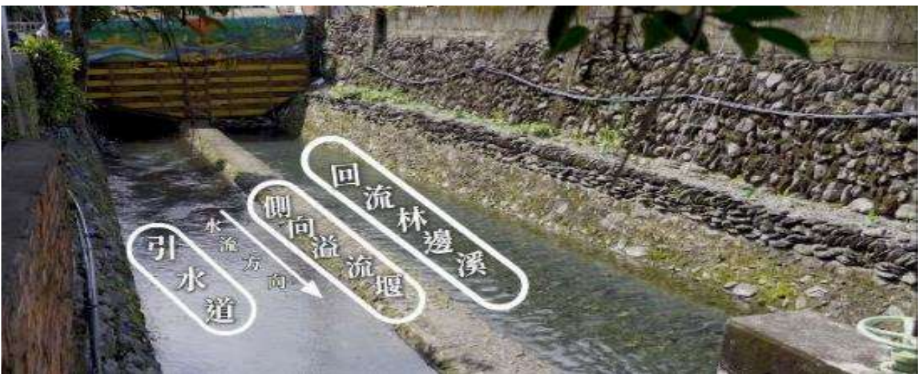
圖12: 二峰圳導水路側向溢流堰
