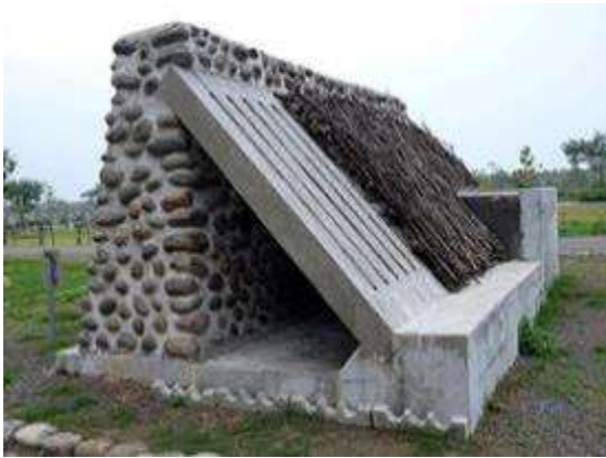
圖3.地下梯形堰堤
