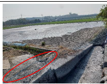
圖 2-3 電線被燒熔在地上
