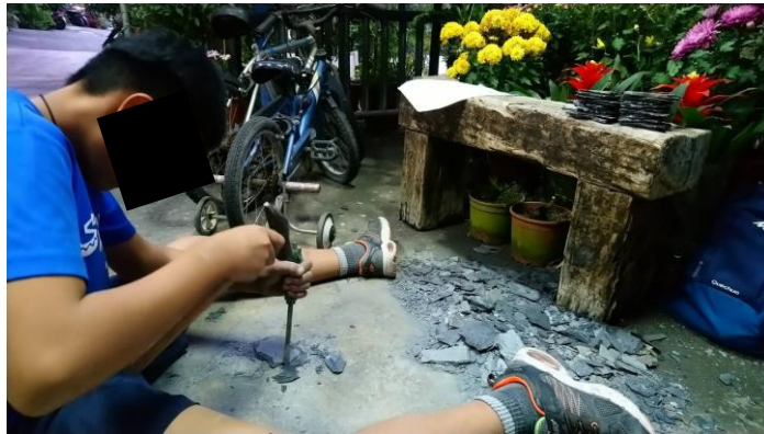
圖六：傳統切割石板的方式是利用鐵片及錘子
