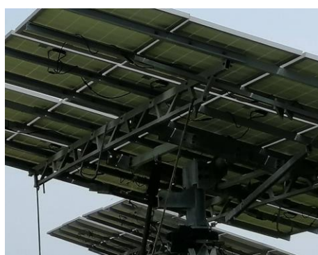
圖〈12〉追日型太陽光電板裝設感應馬達。
