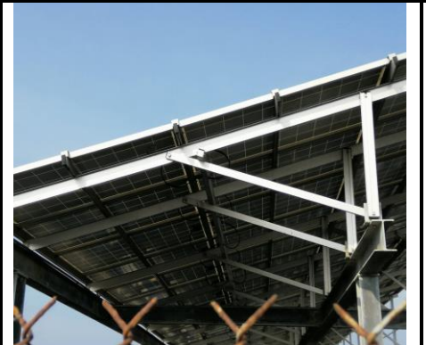
圖〈11〉測量太陽能光電板安裝的仰角，約為20度至25度
