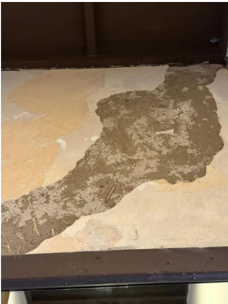
(圖一. 竹編泥牆實拍)
