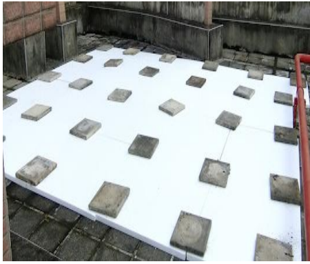
圖3-4 高密度保麗龍屋頂（資料來源： https://www.mobile01.com/topicdetail.php?f=335&t=1645641 使用保麗龍(保龍) 讓頂樓 樓頂 隔熱 達到降溫的目的)
