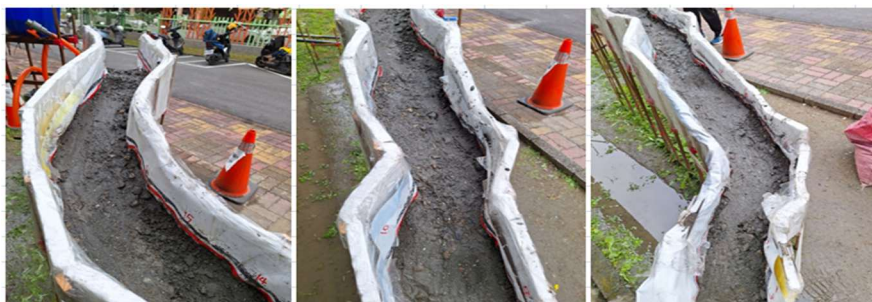
圖 3-5-1、渠道砂石鋪設並註記標線標點
