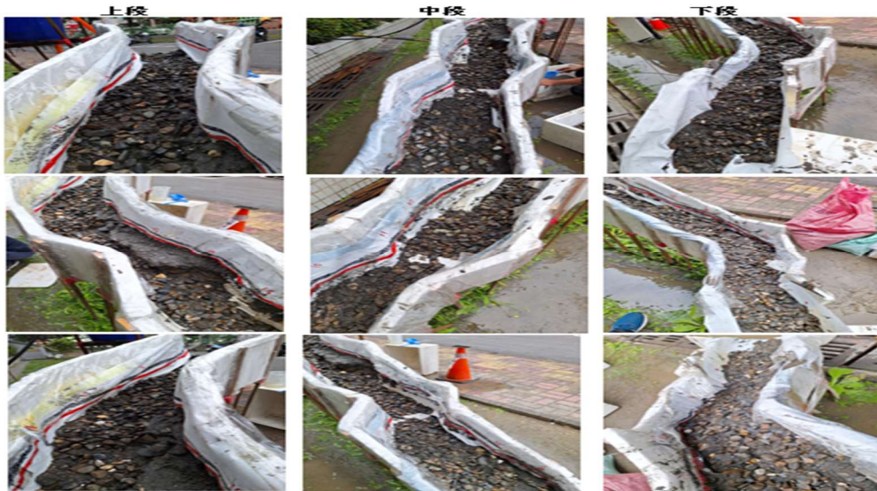
圖 3-5-10、進水 27 L/min 沖刷後渠道內砂石情況
