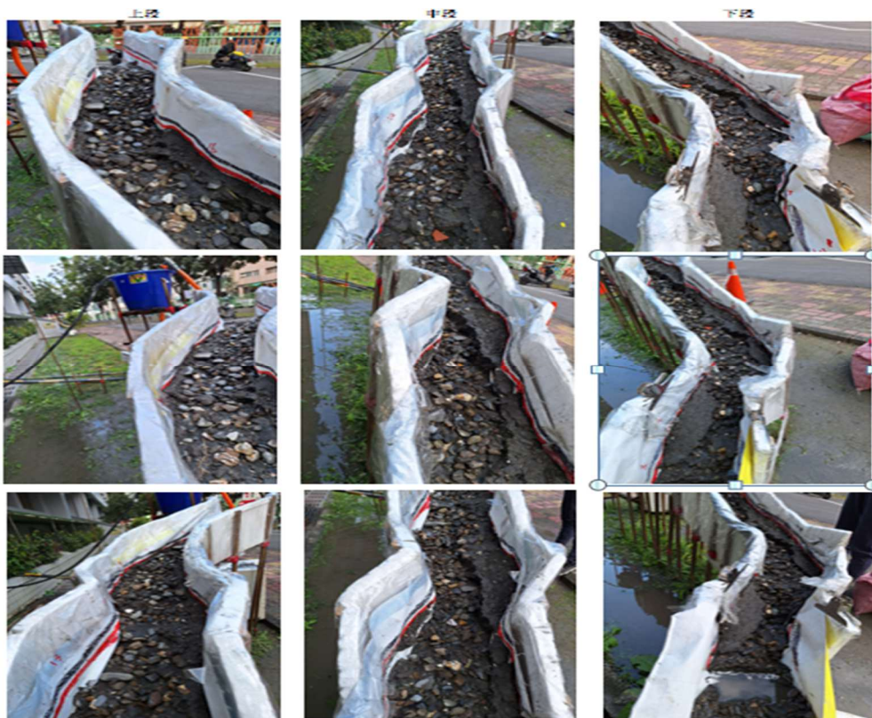
圖 3-5-3、進水 15 L/min 沖刷後渠道內砂石情況
