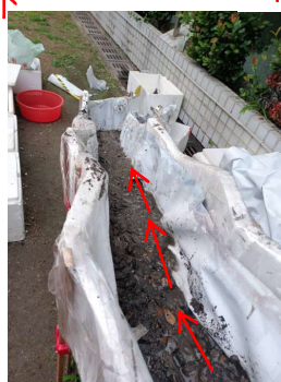
如圖 3-5-11、渠道內水流行進方向
