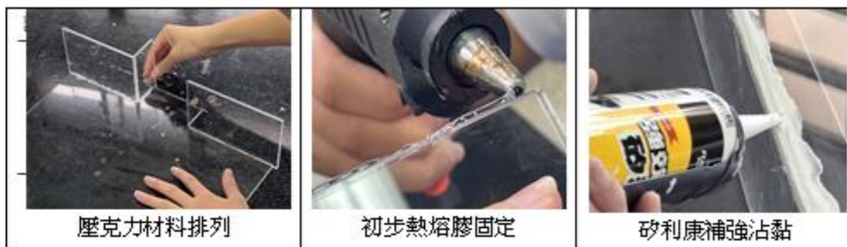
圖 02 為港溪水力河道模型的組合
