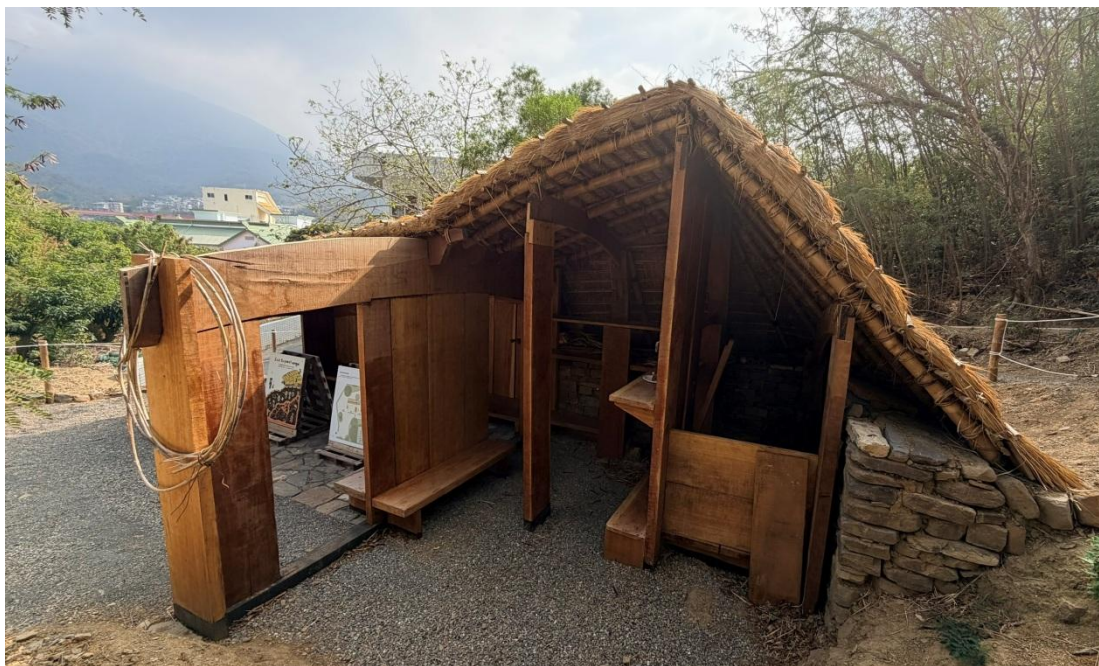
圖 1-1：實地參訪內文式龜甲屋（半棟家屋）
