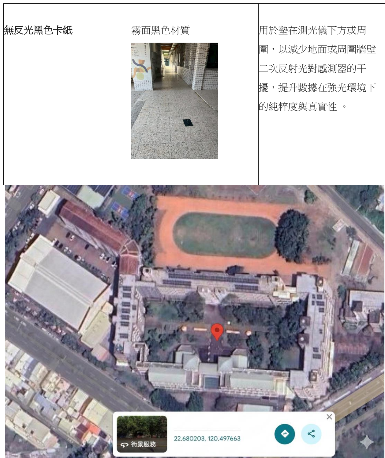
圖 1：本研究之實驗場域全景。右側為起點特教大樓，左側為終點體育館，中間跨越科學實驗大樓與開闊中庭。
