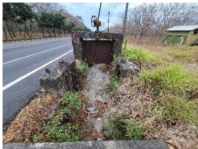
圖 2-41 第 6 個水閘門(沒水)
