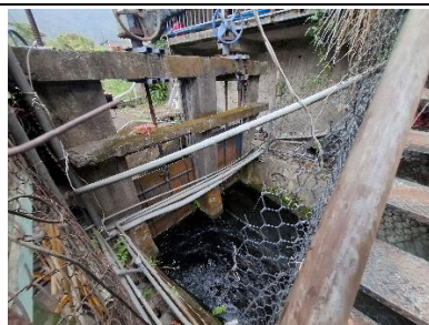
圖 2-15 流經部落的水閘門
