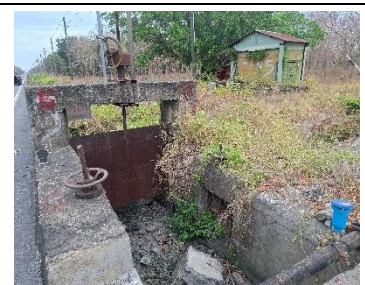
圖 2-40 第 5 個水閘門(沒水)
