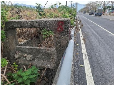
圖 2-44 第 8 個水閘門(沒水)
