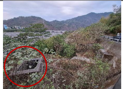
圖 2-19 暗渠的豎井口 (以上照片皆為組員拍攝)
