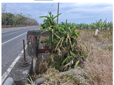
圖 2-43 第 7 個水閘門(沒水)
