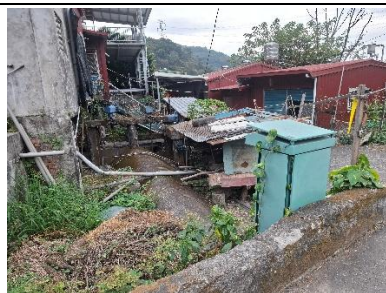
圖 2-14 部落的暗渠水道
