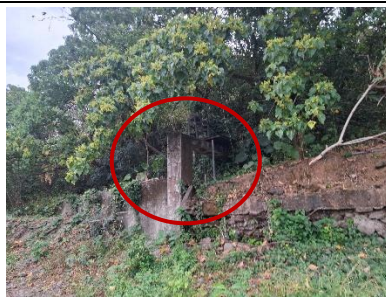
圖 2-18 暗渠的水閘門
