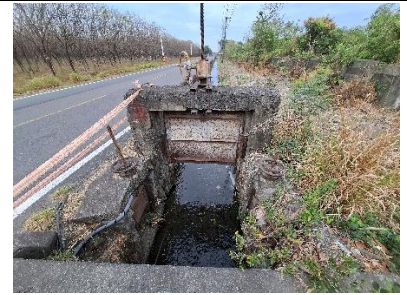
圖 2-37 第 3 個水閘門 (以上照片皆為組員拍攝)
