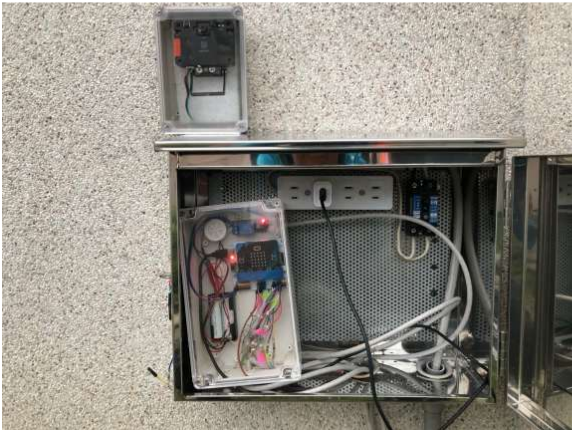
圖二：micro:bit 機板、相關配線及電源設置完成（現場圖）
